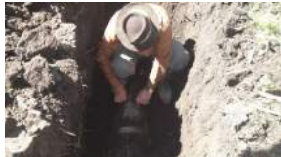
Excavación para ver estado de tubería
