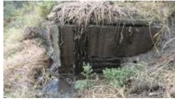
Condiciones operación de la planta
