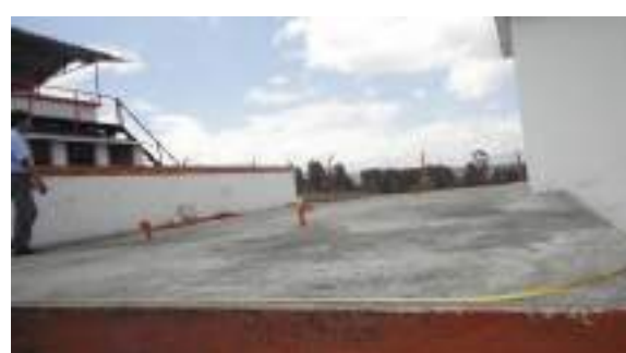
Tanque rectangular de 120 m 3
