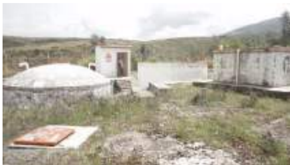
Vista general de la planta
