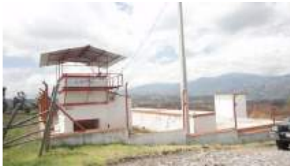
Vista general de la planta
